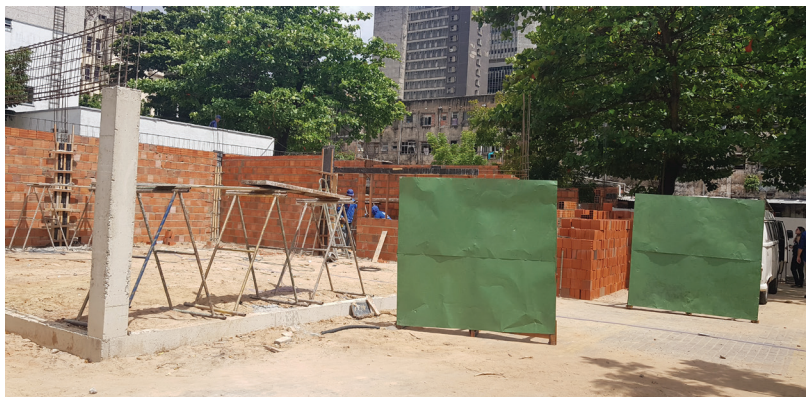
Imagem da execução das obras em andamento
