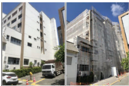
Acompanhamento da Obra de Reforma da Fachada
