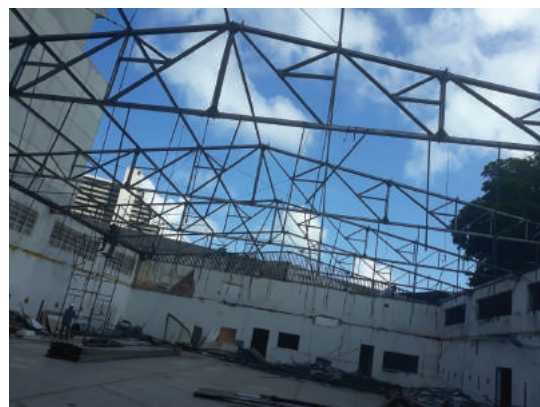
Acompanhamento da Obra do Anexo III
