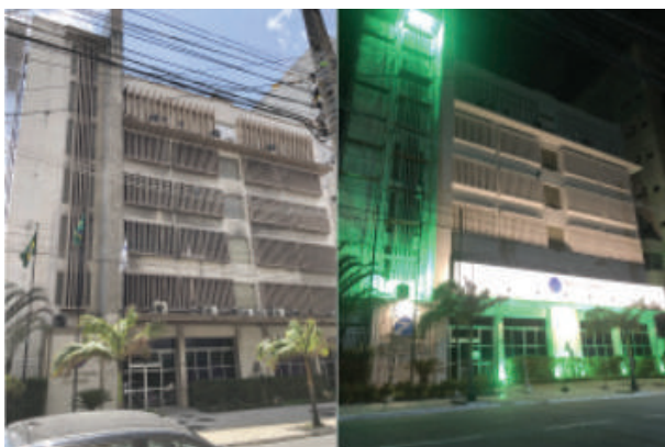
Acompanhamento da Reforma da Fachada
