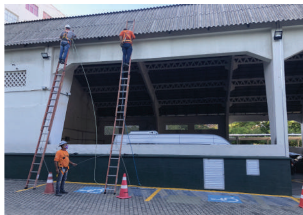
Obra de Execução do Sistema de Proteção de Descargas Atmosféricas (Aterramento) do Galpão
