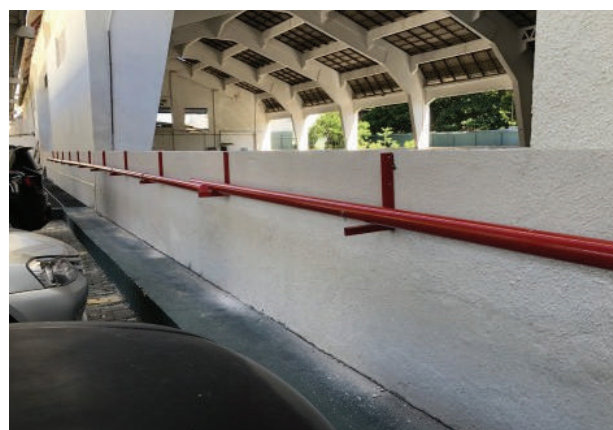
Obra do Sistema de Proteção e Combate a Incêndio (em andamento)
