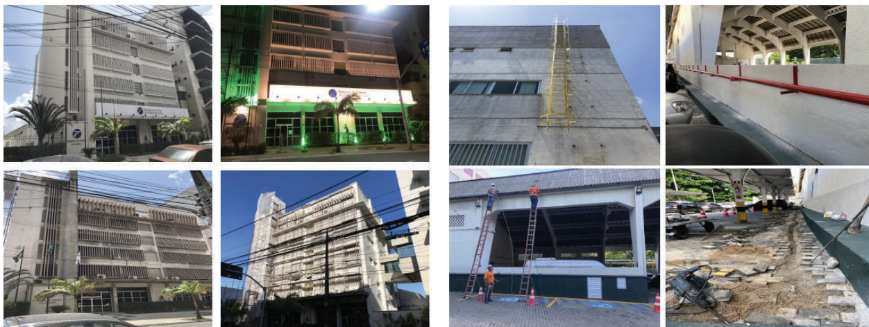
Acompanhamento Reforma Fachada Ed. Sede
