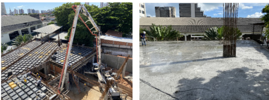
Acompanhamento da obra do Anexo III
