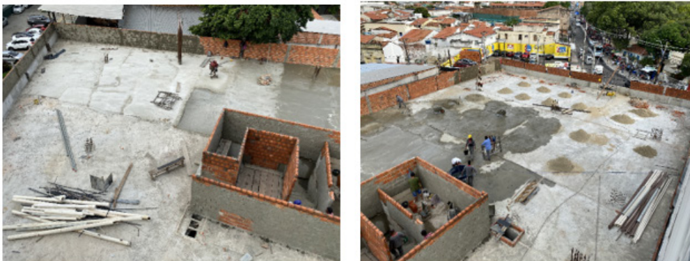
Acompanhamento da obra do Anexo III
