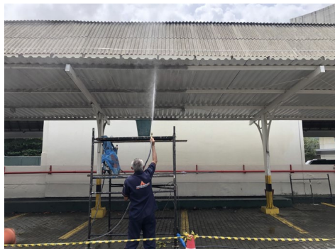
Limpeza e Manutenção as Cobertas do Estacionamento
