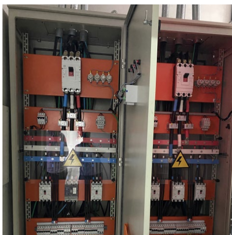
Reforma dos quadros elétricos do Ed. Sede
