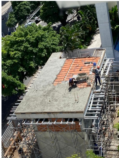
Vista Aérea da Estrutura
