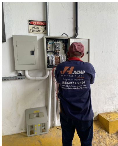
Acompanhamento da Instalação do novo circuito de alimentação elétrica no quadro de energia do Arquivo da Secretaria de Serviços Processuais
