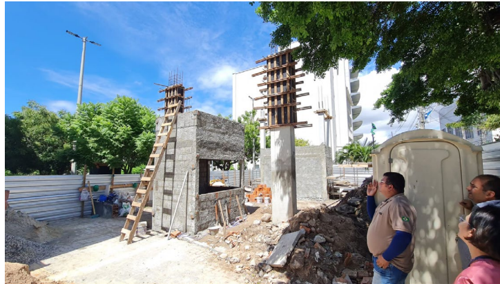
Canteiro de Obras
