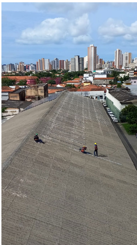
Montagem da Fixação dos Painéis
