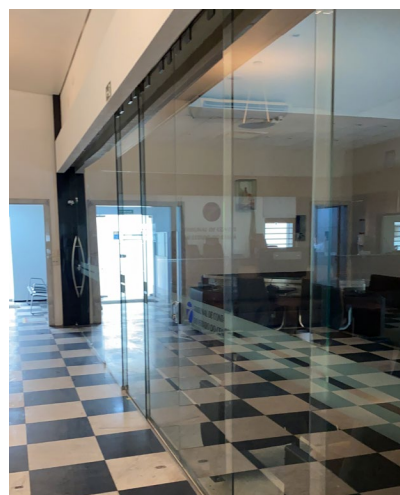
Correção dos trilhos que sustentam as vidraças do Plenário Ed.Sede
