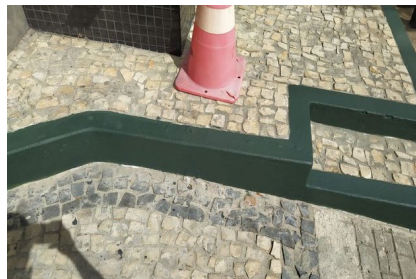
Foto 05 – Repintura das Calçadas e Meio Fio Internos
