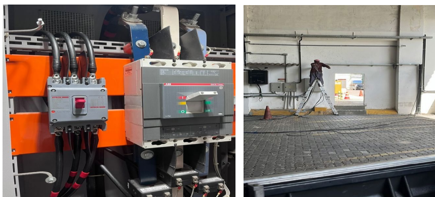
Imagens da obra de implantação do sistema de energia solar
