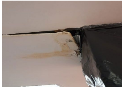
Foto 02 – Recomposição de Forros e Pintura no Plenário
