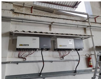
Foto 04 – Construção Coberta Inversores
