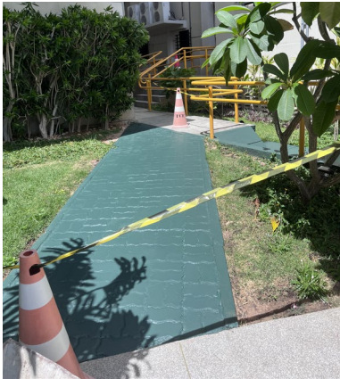
Foto 01 – Repintura das Calçadas e Meio Fio Internos
