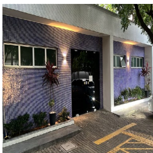
Foto 11 – Iluminação Fachada Assessoria de Saúde
