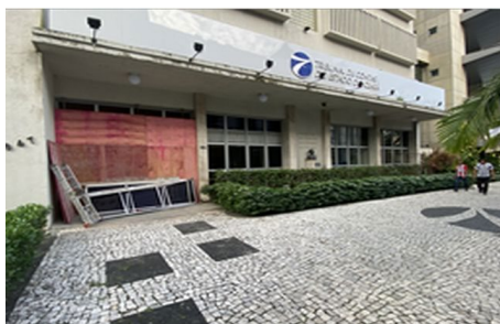
Fechamento com Tapume
