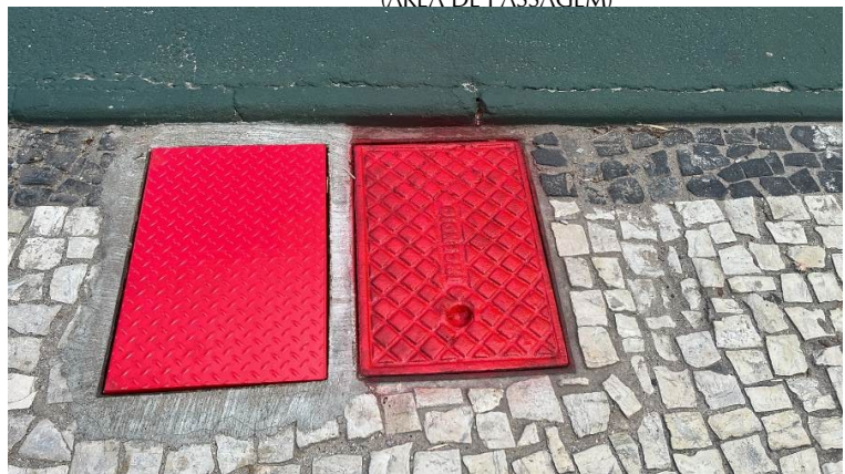
PINTURA E REFORMA DAS TAMPAS DOS HIDRANTES DE PASSEIO
