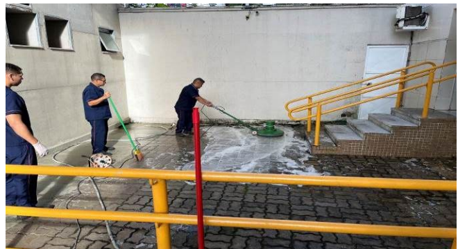
LIMPEZA E DESINFECÇÃO DO PISO INTERTRAVADO (ÁREA DE PASSAGEM)
