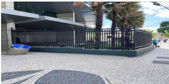
Foto 1 – Pintura e Padronização dos Gradis do Ed. 5 de Outubro – Anexo II
