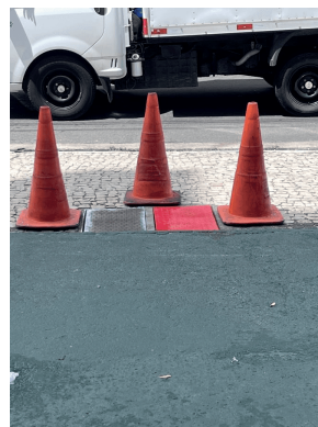
Foto 02 – Pintura e reforma das tampas dos hidrantes de passeio
