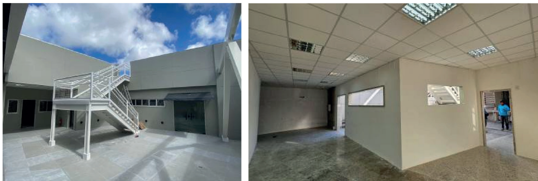
IMAGENS ILUSTRATIVAS DO PROJETO E EXECUÇÃO DA REFORMA DO 8º ANDAR DO EDIFÍCIO 5 DE OUTUBRO
