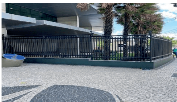
Foto 03 – Pintura e Padronização dos Gradis do Ed. 5 de Outubro – Anexo II
