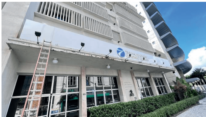
Foto 01 – Repinturas na Fachada do Ed. Sede
