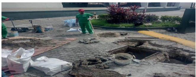
Foto 3 - Reforma e recomposição de caixas de drenagem
