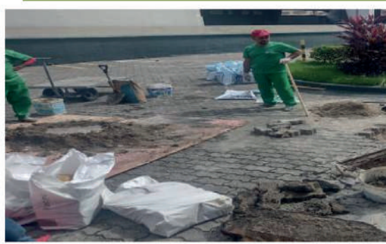
Foto 4 - Reconstrução da Caixa de drenagem
