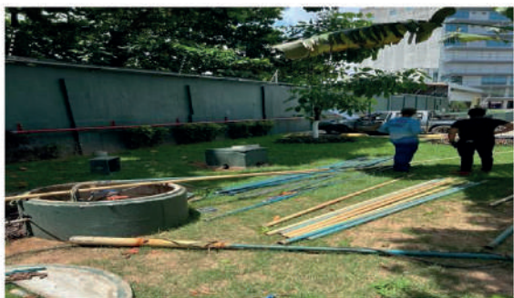
Foto 3 - Limpeza e higienização do poço profundo
