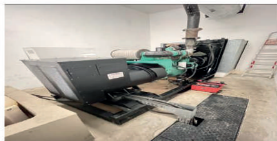
Foto 2 - Revisão geral do grupo de geradores
