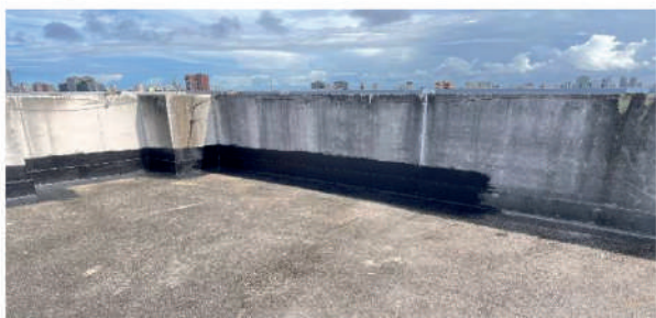
Foto 1 - Impermeabilização da cobertura do Ed. Anexo II
