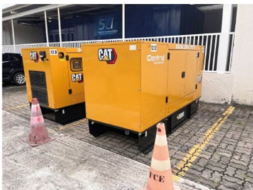
Foto 1 – Manutenção da Subestação
