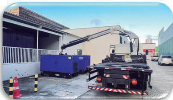
Foto 03 – Manutenção de Subestação
