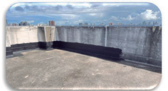
Foto 06 – Impermeabilização do Ed. Anexo II
