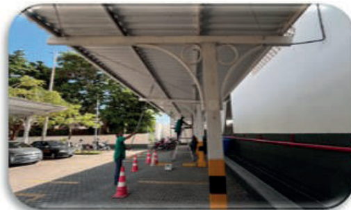
Foto 06 – Limpeza e pintura das luminárias
