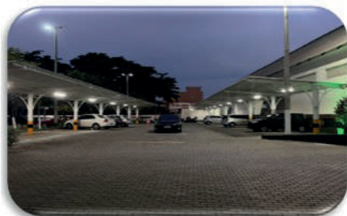
Foto 05 – Limpeza e pintura das luminárias
