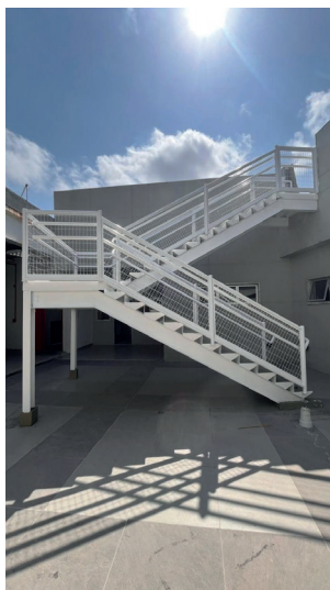
Foto 1 – Repintura e Manutenção em Escada Heliponto
