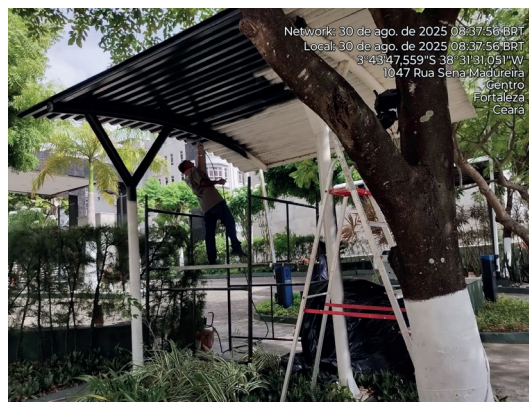
Foto 6 – Pintura das Cobertas Cancelas Entrada/Saída
