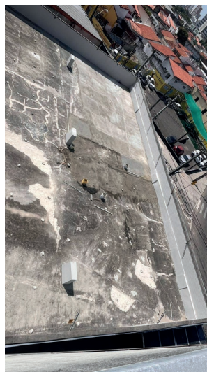
Foto 4 – Execução de Proteção Mecânica no Anexo III
