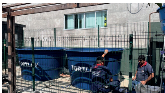
Foto 5 – Novas Instalações da Cisterna do IPC
