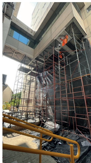
Foto 2 – Repintura de Manutenção da Estrutura Metálica Passarela
