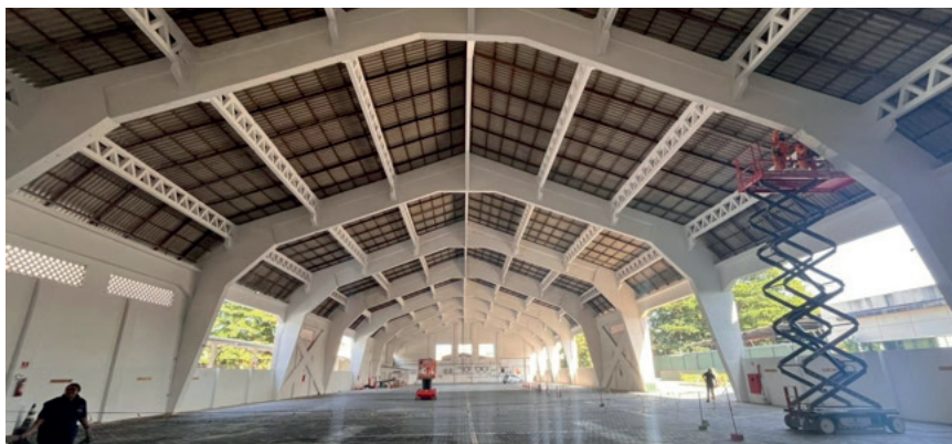
Acompanhamento da Manutenção do Galpão Estacionamento
