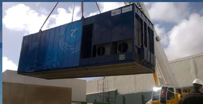
Instalação do Contêiner Datacenter, no dia 28 de abril de 2015.
