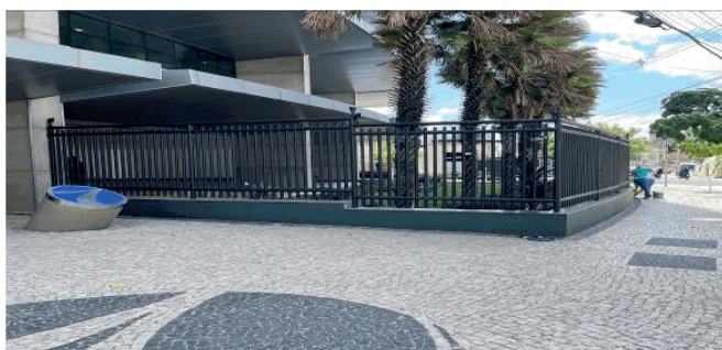
Foto 03 – Pintura e Padronização dos Gradis do Ed. 5 de Outubro – Anexo II
