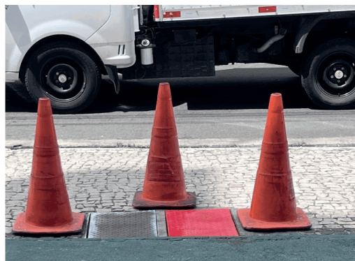
Foto 02 – Pintura e reforma das tampas dos hidrantes de passeio;
