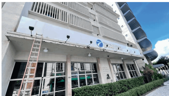
Foto 01 – Repinturas na Fachada do Ed. Sede;
