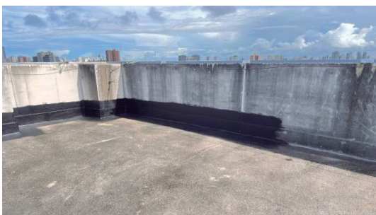
Foto 06 – Impermeabilização do Ed. Anexo II
