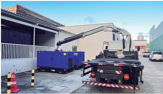
Foto 03 – Manutenção de Subestação
