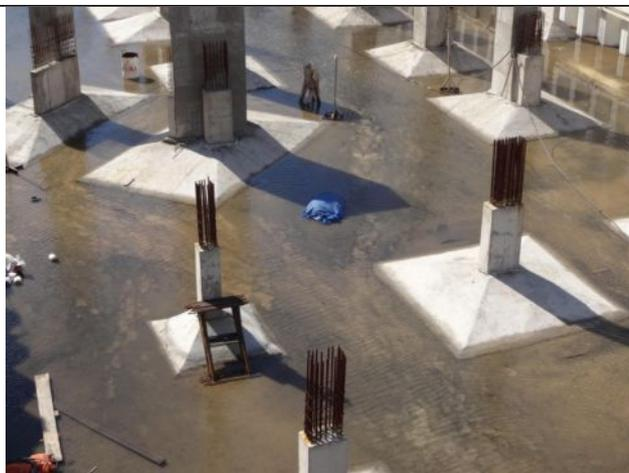
Foto 2: Detalhe da saída dos pilares
