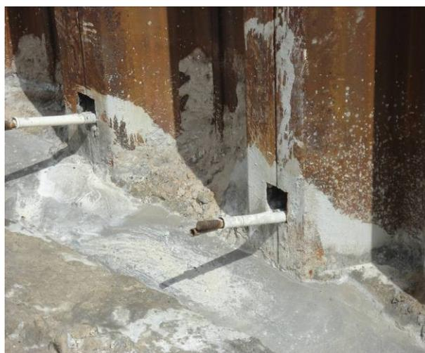
Foto 2: Atirantamento das estacas-prancha
