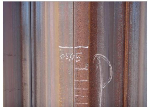
Figura 06 – Detalhe da marcação do nível de corte das estacas-prancha.
