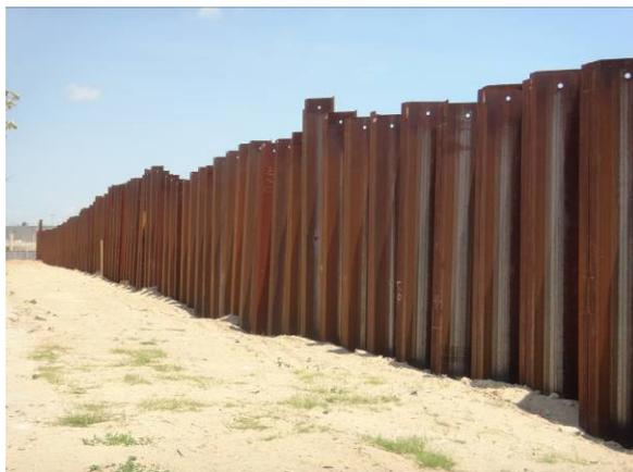
Figura 03 – Vista externa da área a ser construída – estacas-pranchas cravadas.
