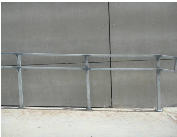
Figura 01 – Corrimãos instalados de acordo com a altura recomendada pela NBR 9050/2004.
