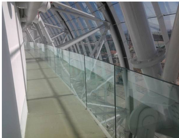
Foto/Figura 01 – Guarda-corpos localizados no pavimento N5.
