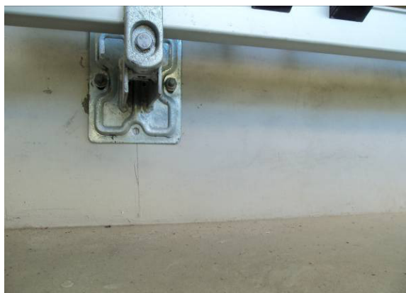
Foto/Figura 03 – Base de metal fixada com 2 parafusos na posição horizontal.
