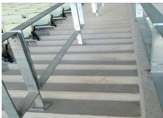
Foto/Figura 03 – Base de metal fixada com 2 parafusos na posição horizontal.
