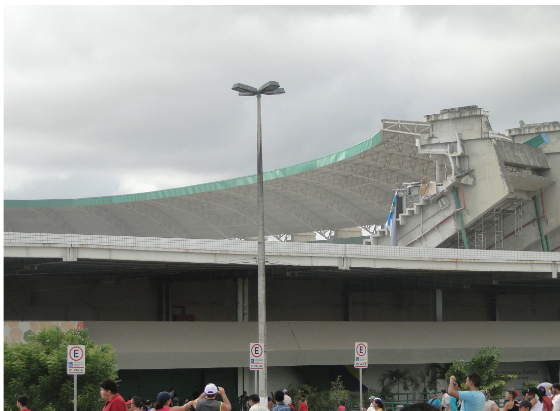
Figura 16 – Prédio atual da Secretaria de Esporte foi preservado durante a implosão (12.06.2011)
