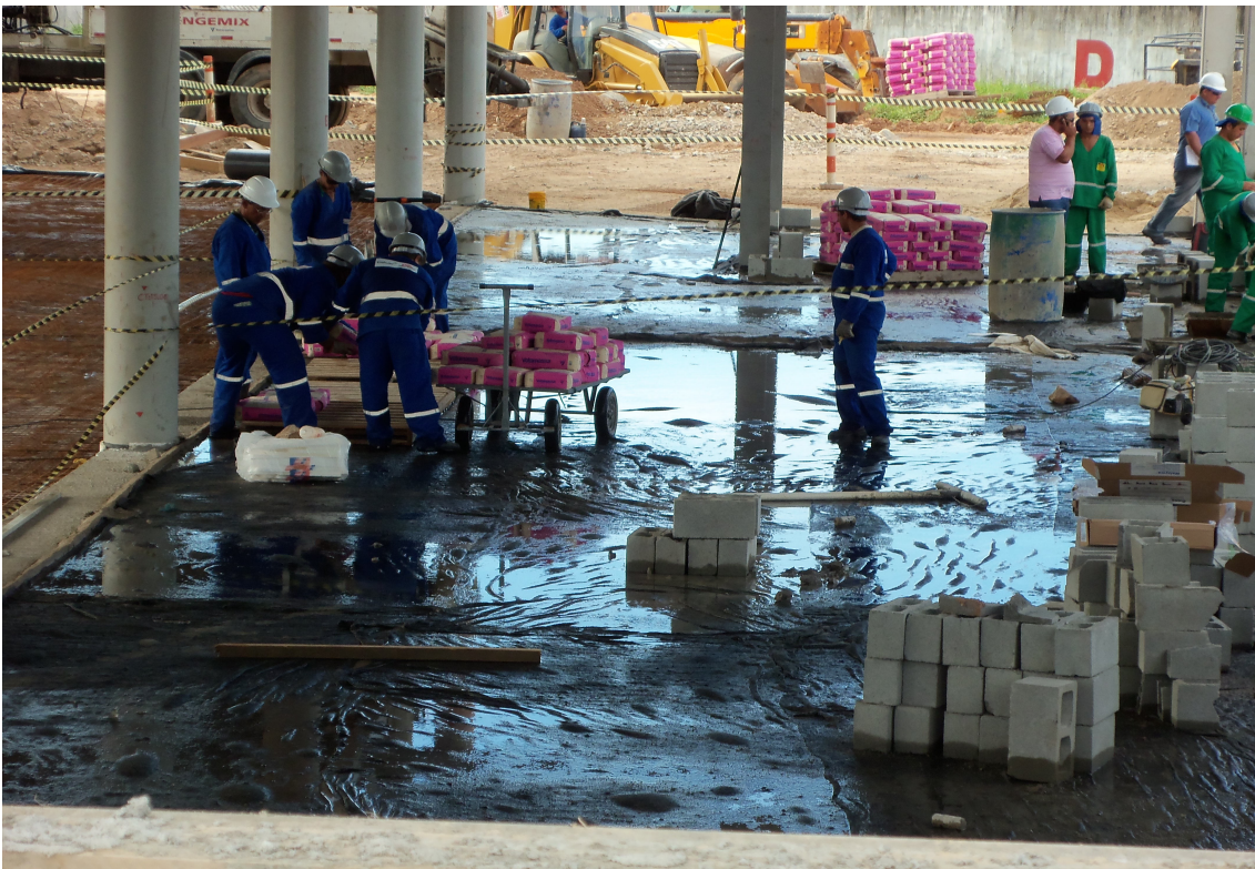
Figura 06 – Execução do piso do Estacionamento – Etapa 1 (07.06.2011)
