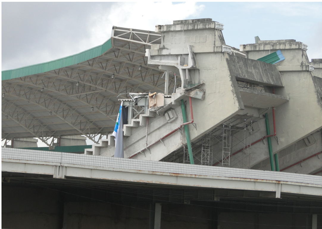
Figura 15 – Detalhe da estrutura remanescente do Estádio imediatamente após a implosão (12.06.2011)
