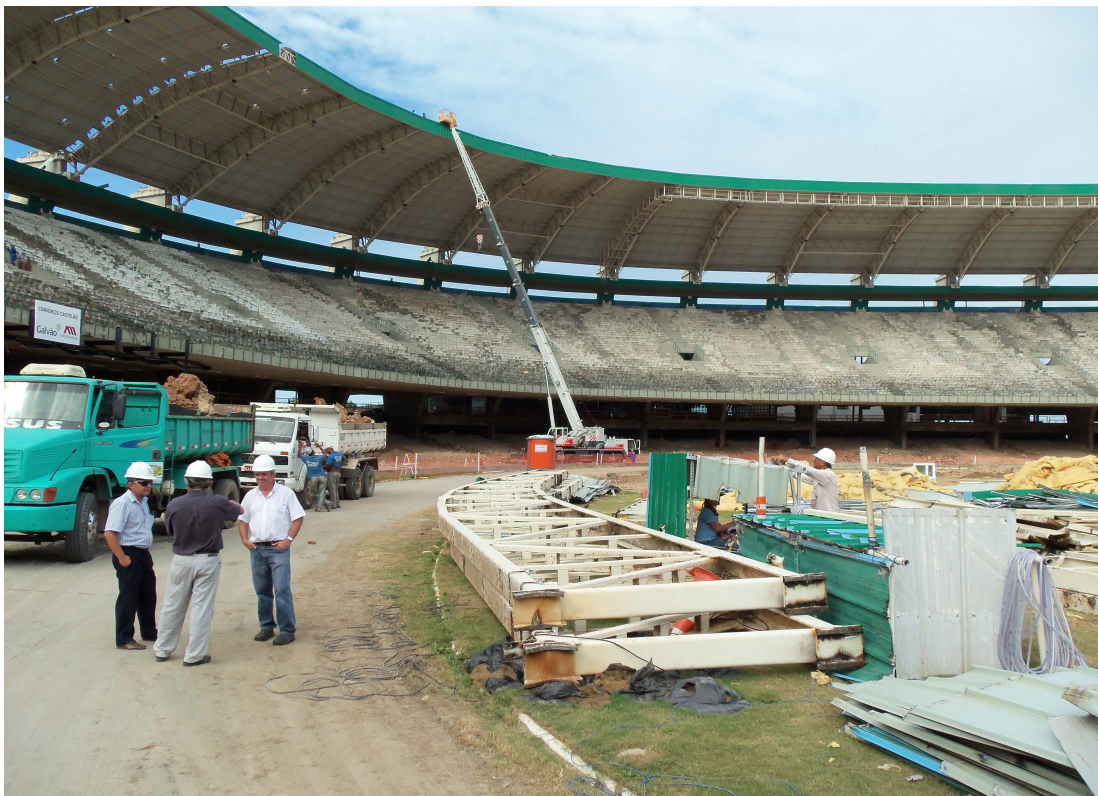
Figura 04 – Remoção das cadeiras das arquibancadas concluída (07.06.2011)
