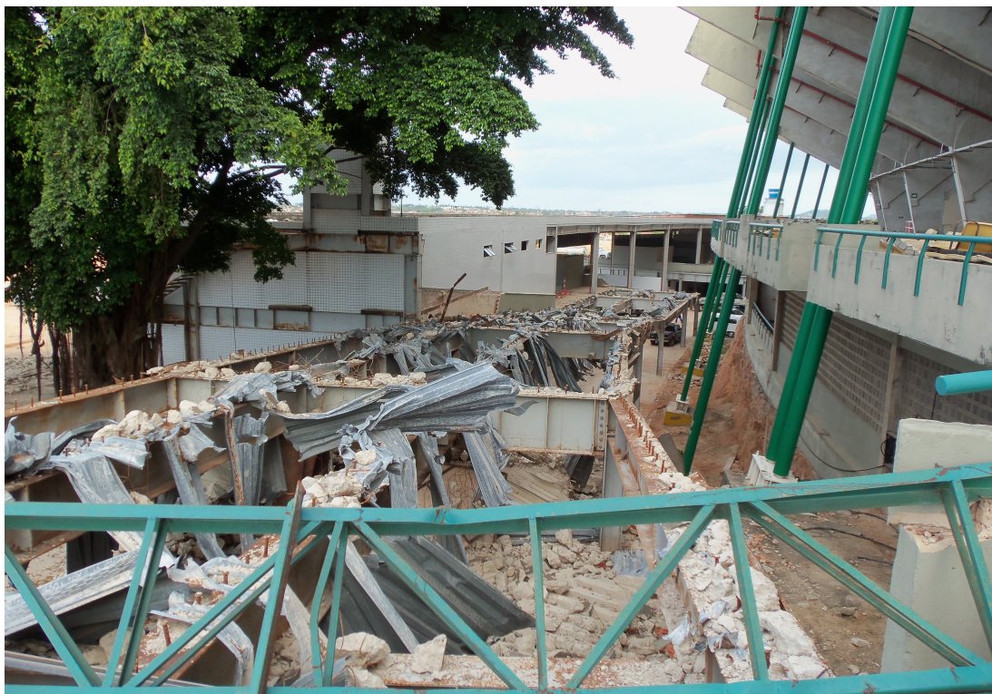
Figura 10 – Área externa ao Estádio ainda prevista para demolição (07.06.2011)
