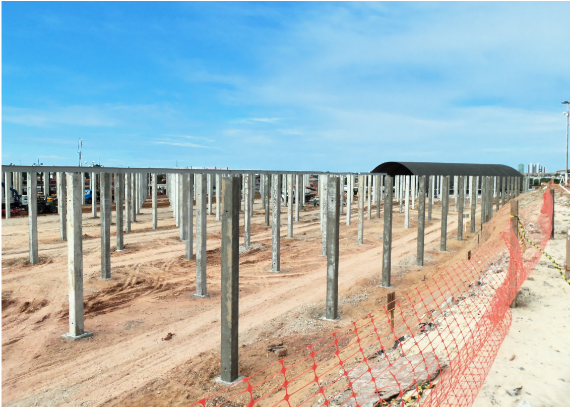
Figura 05 – Vista geral do Estacionamento – Etapa 1 (07.06.2011)
