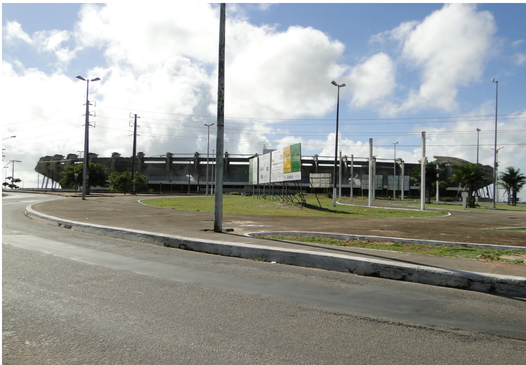
Figura 13 – Vista do Estádio antes da implosão (12.06.2011)
