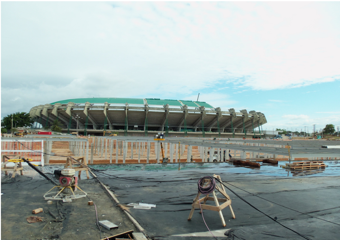
Figura 09 – Visão geral da área do Estacionamento e da Secretaria do Esporte - Etapa 1 (07.06.2011)
