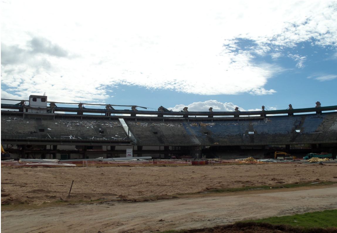
Figura 03 – Remoção de cobertura metálica concluída na área definida para implosão a ser realizada no dia 12.06.2011 (07.06.2011)
