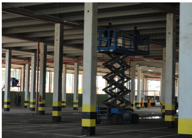
Foto 02 - Homens trabalhando na instalação elétrica
