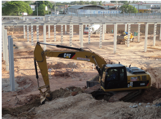
Foto 26 – Área do estacionamento coberto 2 (Etapa 2)
