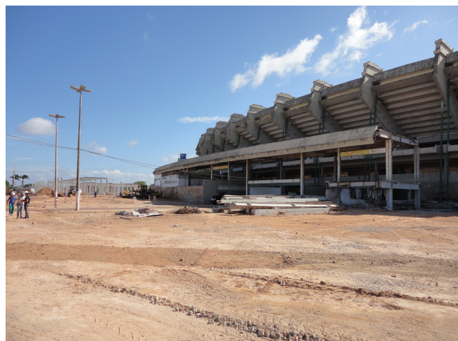
Foto 27 – Área externa do estádio Castelão (etapa 4)
