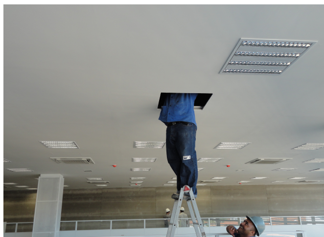
Foto 23 – Operários trabalhando no sistema elétrico do prédio da SESPORTE
