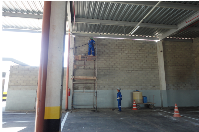
Foto 08 – Homens trabalhando na execução de alvenarias
