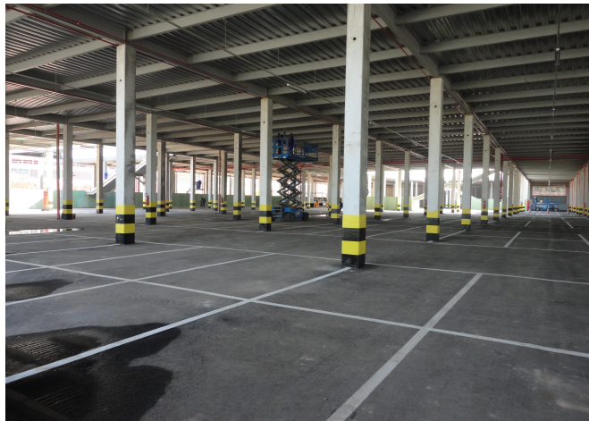
foto 01 - Laje de cobertura e área do estacionamento 1 – sem teste de impermeabilização
