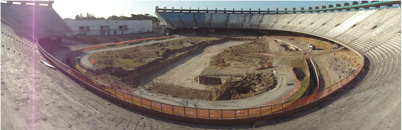
Foto 25 – Panorâmica interna do estádio Castelão (Etapas 3 e 4)
