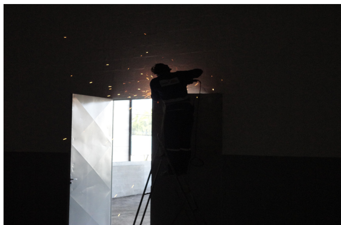
Foto 09 – Homens trabalhando na serralheria – portões de aço
