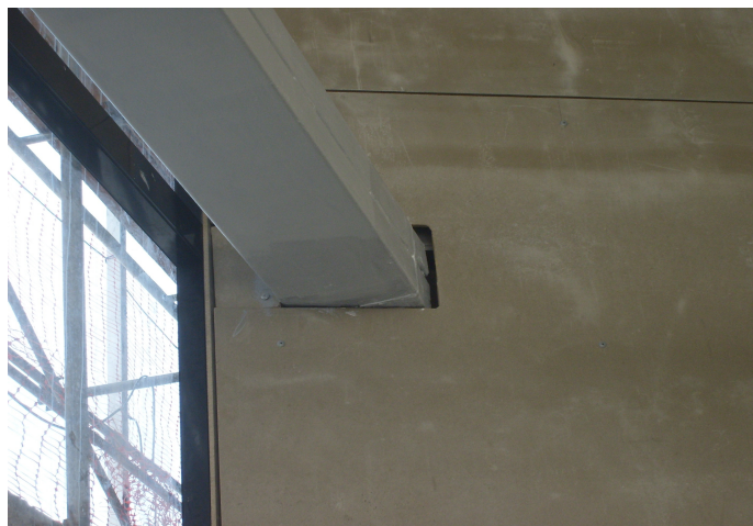
Foto 05 – recortes nos painéis Viroc sem acabamento
