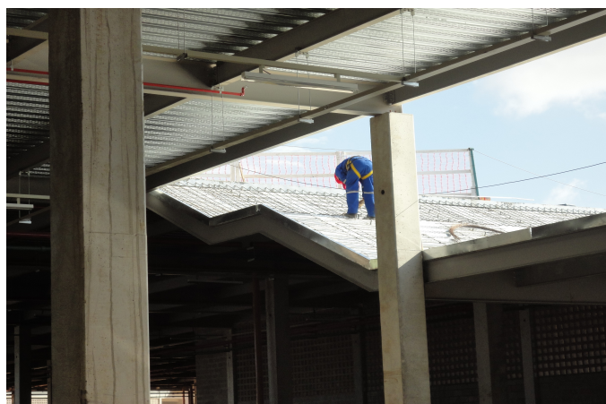
Foto 06 – Homens trabalhando nas escadas / rampas de acesso à praça do estádio
