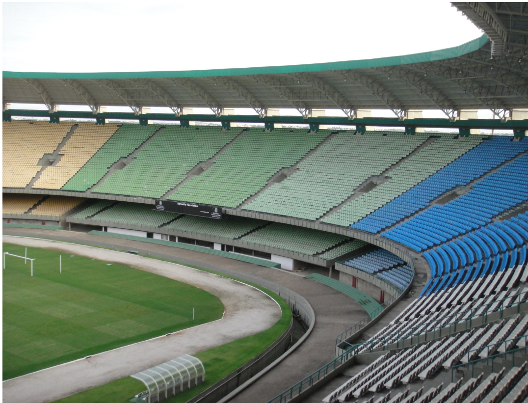
Figura 01 – Visão da arquibancada e cobertura metálica que serão ampliados
