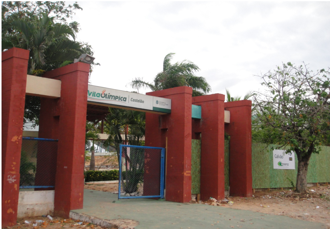
Figura 02 – Vila Olímpica que será demolida para construção do edifício-sede da Secretaria de Esportes e estacionamento 01
