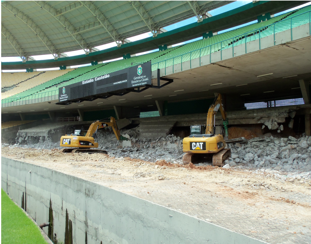
Figura 03 – Detalhe com as máquinas trabalhando no local
