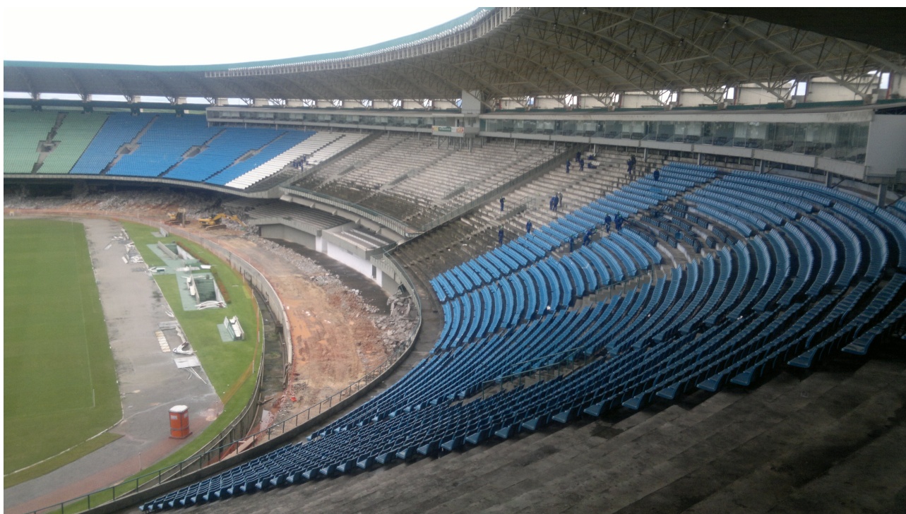
Figura 08 – ETAPA 03 – Vista da remoção das cadeiras do Estádio (data: 13/04/2011)
