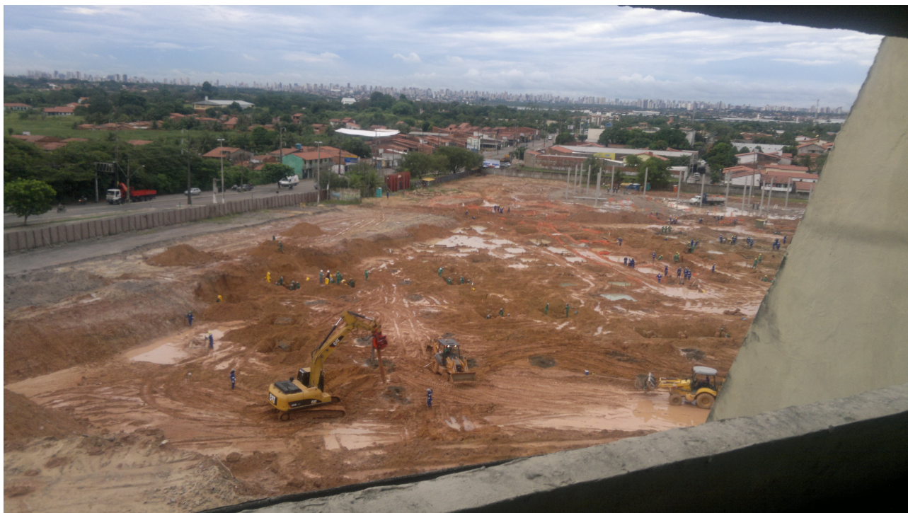
Figura 07 – ETAPA 01 – Vista do local da secretaria e 1ª etapa do estacionamento. Observar detalhe das estacas de reforço de solo sendo produzidas “in loco” (data: 13/04/2011)
