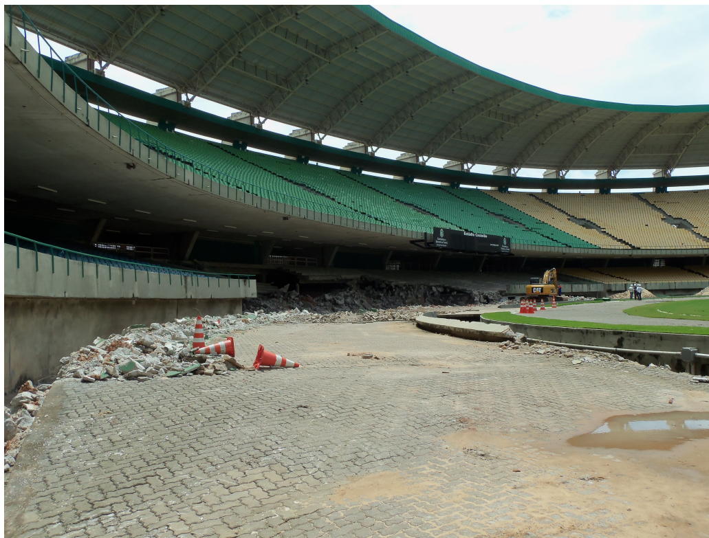
Figura 01 – Trechos iniciais demolidos da arquibancada inferior do Estádio (Em: 05/04/11)
