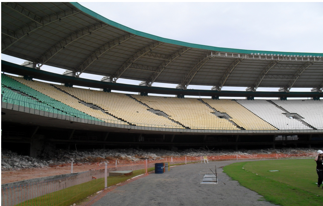
Figura 09 – ETAPA 03 – Visão de parte da área demolida no anel inferior das arquibancadas (data: 13/04/2011)
