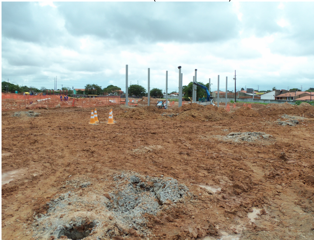
Figura 05 – ETAPA 01 – Área do estacionamento - estacas de reforço de solo produzidas “in loco” (data: 05/04/2011)
