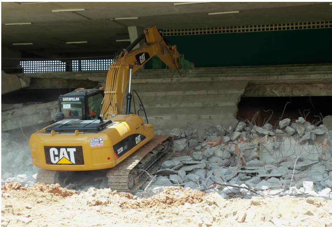
Figura 04 – Detalhe do operador da retro-escavadeira efetuando o serviço de demolição
