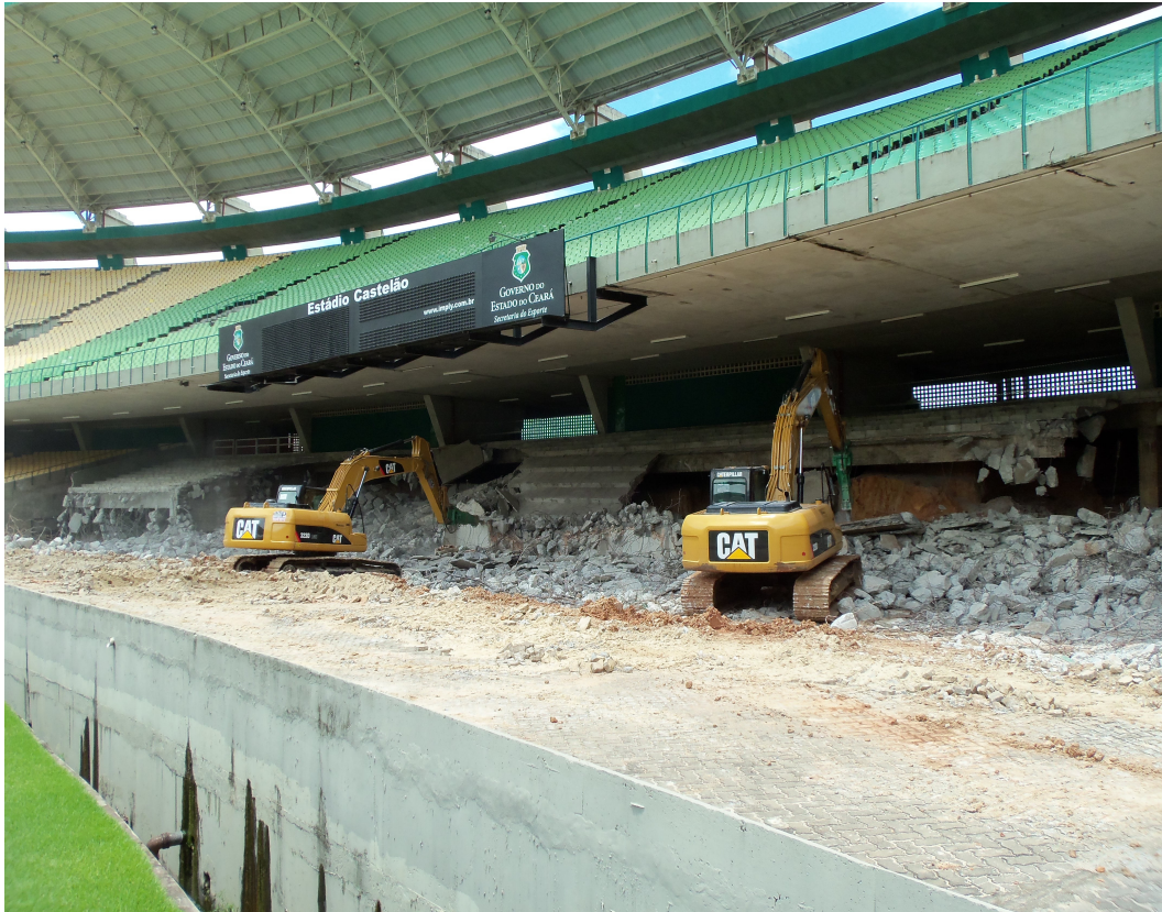
Figura 03 – Detalhe com as máquinas trabalhando no local
