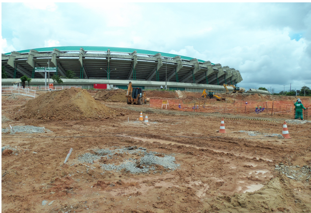
Figura 05 – ETAPA 01 – Área do estacionamento - estacas de reforço de solo produzidas “in loco” (data: 05/04/2011)
