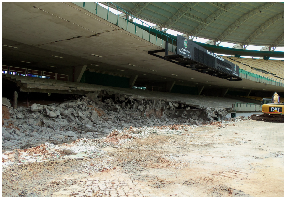
Figura 02 – Destaque de uma área demolida (Data: 05/04/2011)
