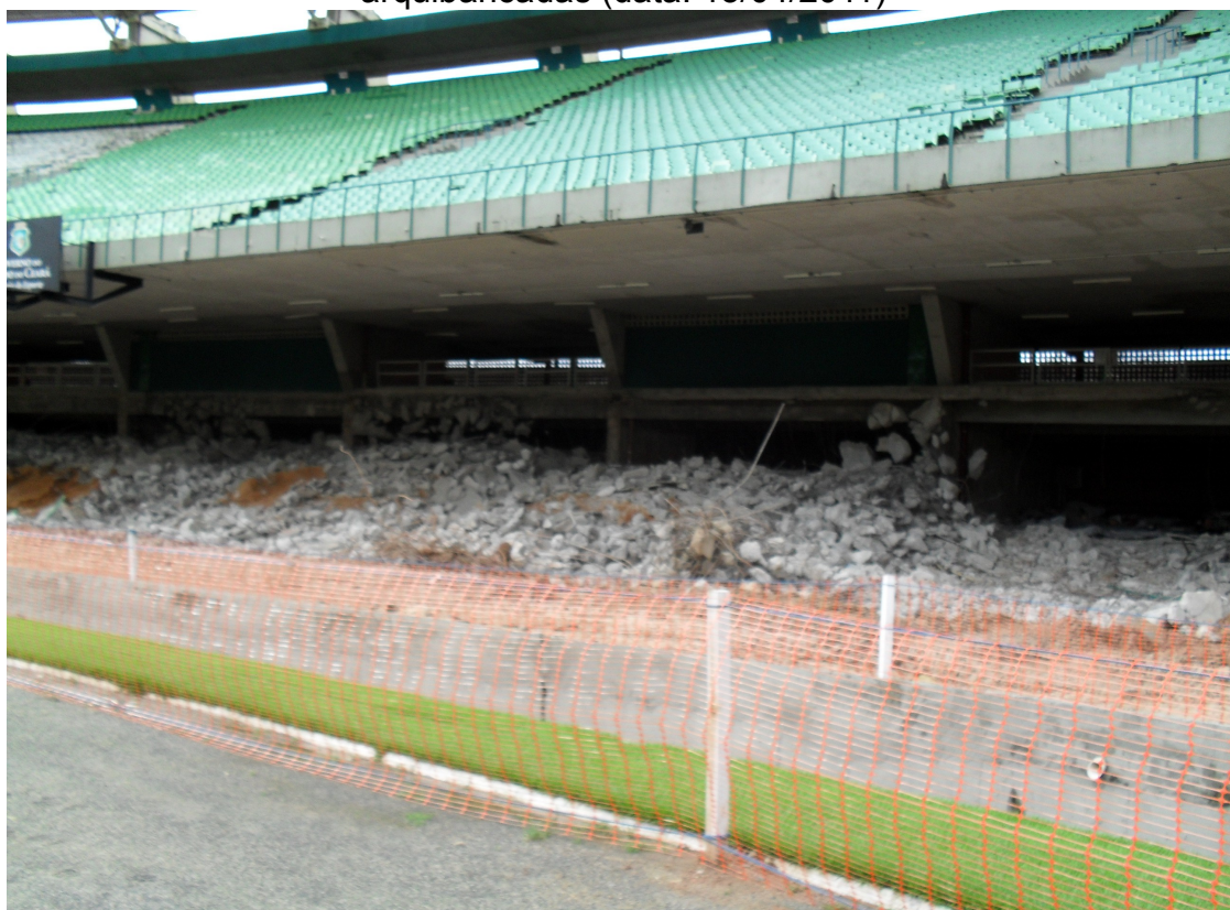
Figura 09 – ETAPA 03 – Visão de parte da área demolida no anel inferior das arquibancadas (data: 13/04/2011)
