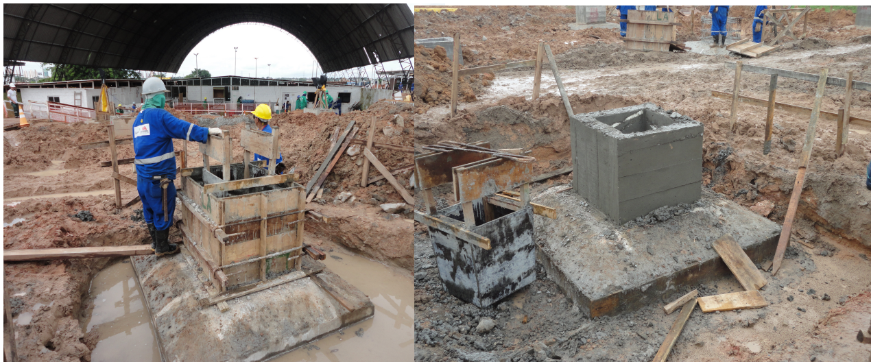
Figura 04 – Concretagem e desforma dos blocos de coroamento realizados em dia chuvoso (11/05/2011)
