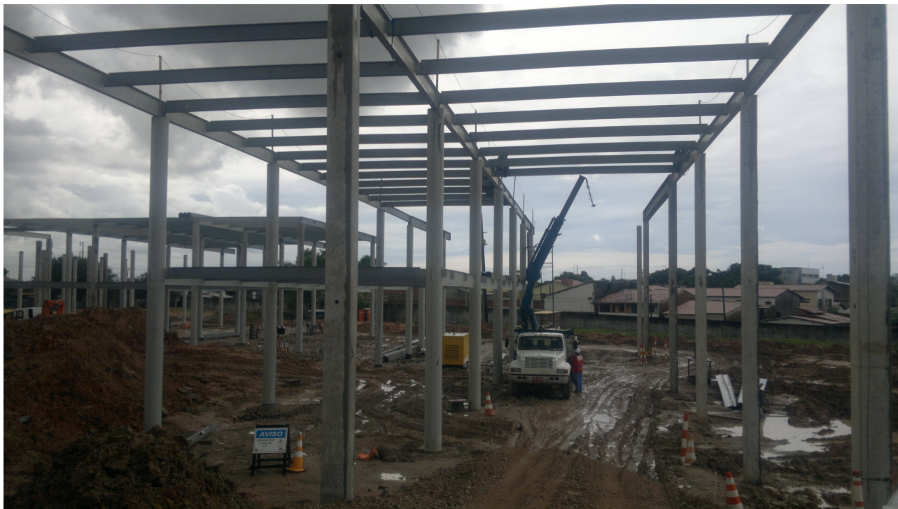
Figura 03 – Instalação de Vigas Metálicas na Secretaria de Esportes (Em 11/05/2011)
