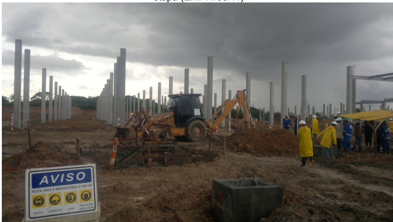
Figura 02 – Estrutura do Estacionamento Coberto – 1ª etapa (Em: 11/05/11)
