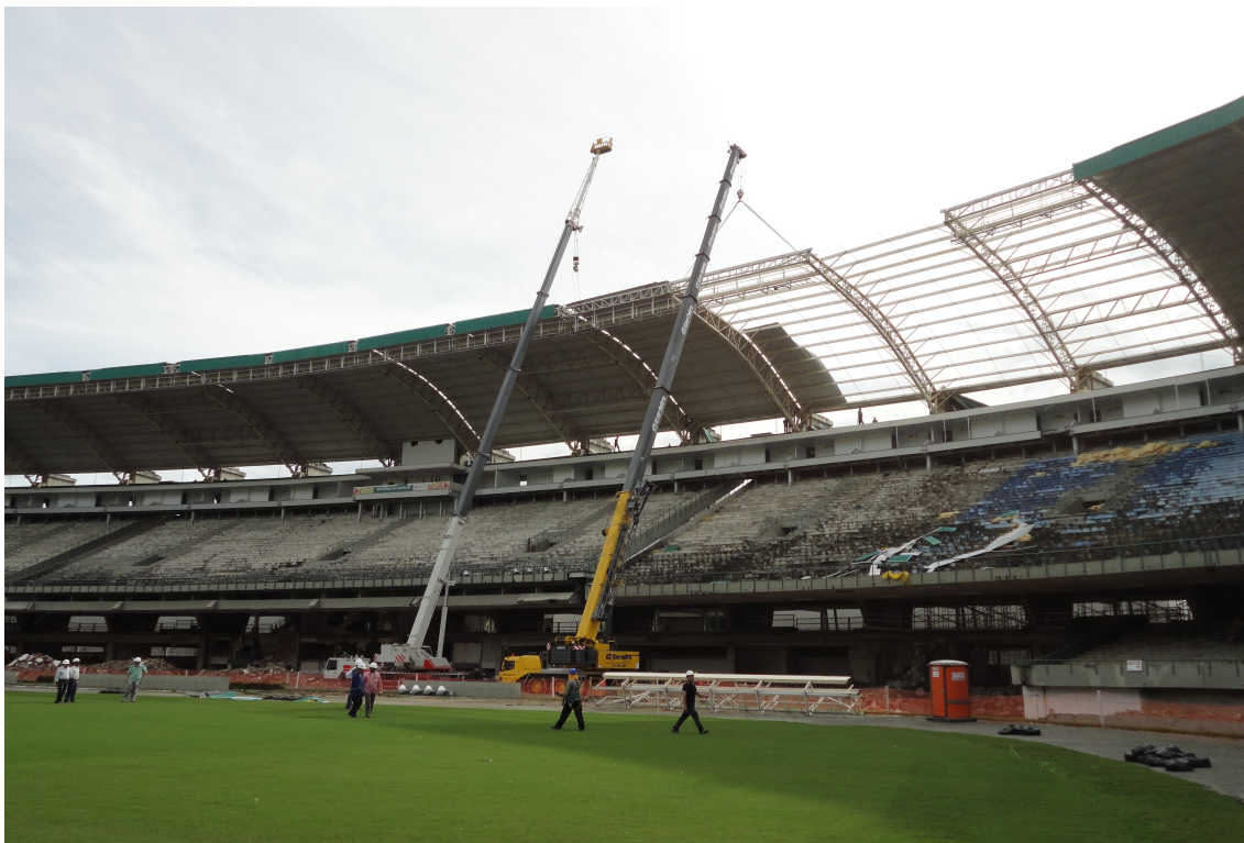
Figura 07 – Trecho da cobertura antes da remoção (11/05/2011)
