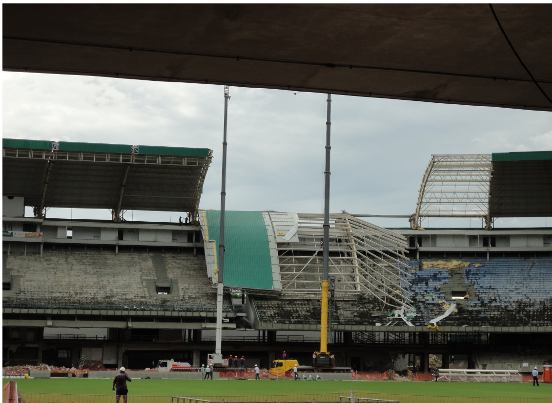
Figura 08 – Trecho da cobertura após a remoção concluída (11/05/2011)
