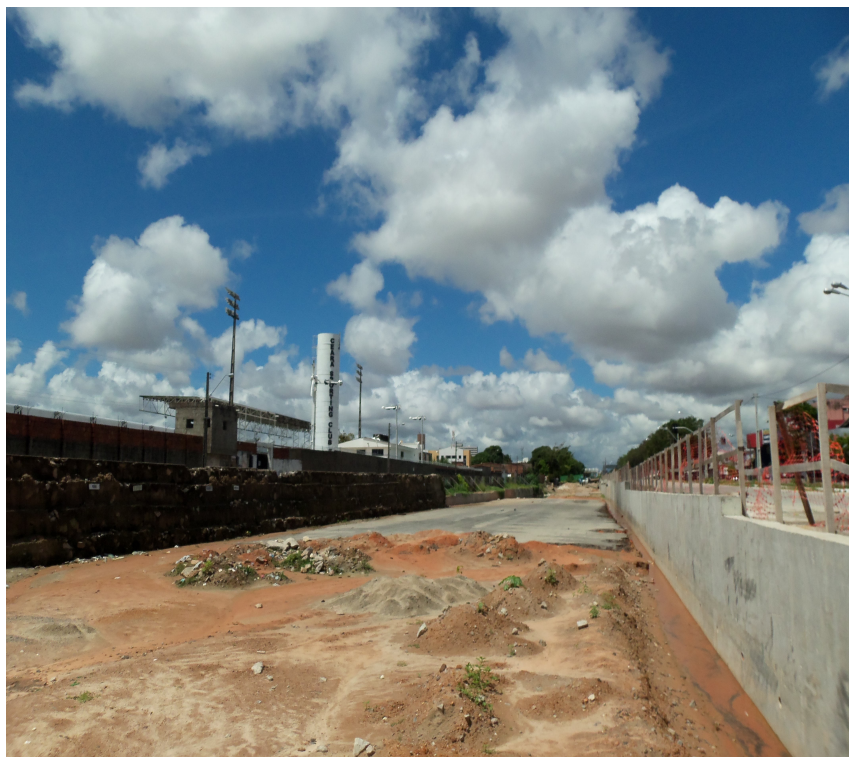
Figura 01 – Local da Estação Pe. Cícero
