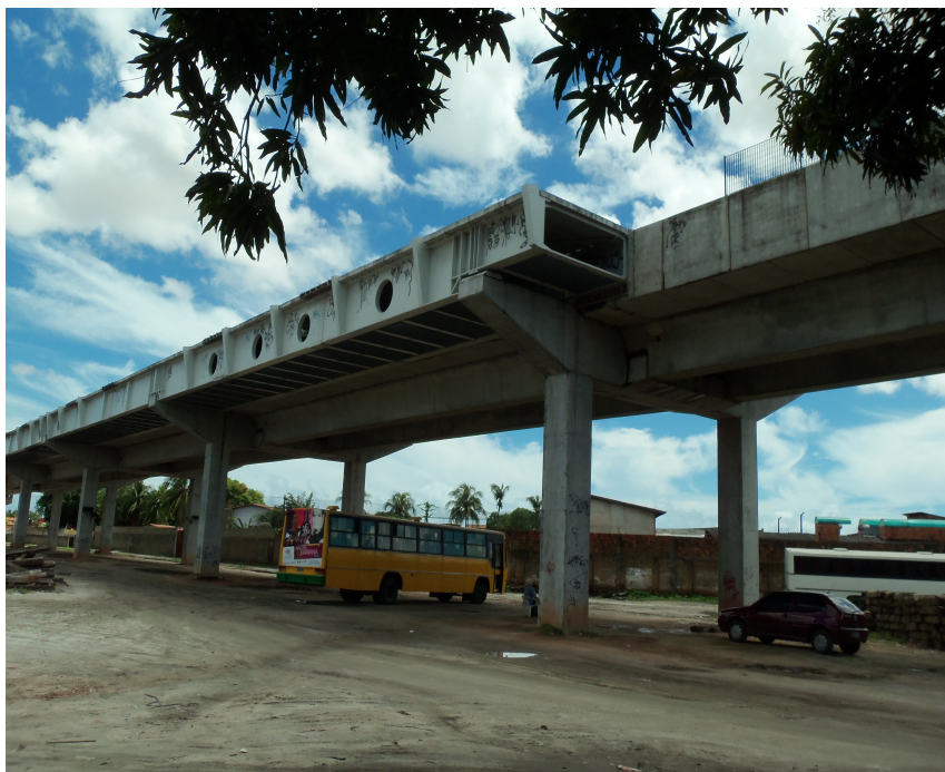
Figura 02 – Local da Estação Juscelino Kubitschek
