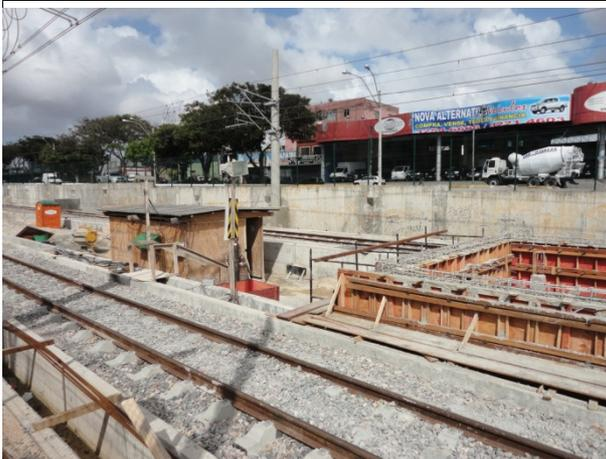
Foto 3 – Execução de vigas baldrame que sustentarão a laje de piso da estação Pe. Cícero.
