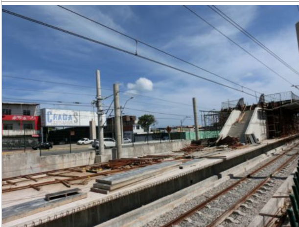
Foto 5 – Vista do canteiro da Estação Padre Cícero – sentido Centro de Fortaleza.
