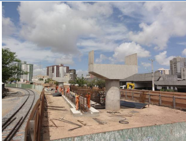
Foto 2 – Pilares de apoio do Elevado da Av. Aguanambi.
