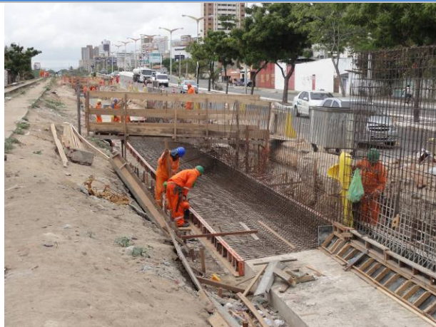
Foto 1 – Execução de muro de arrimo na extensão longitudinal da via Expressa.
