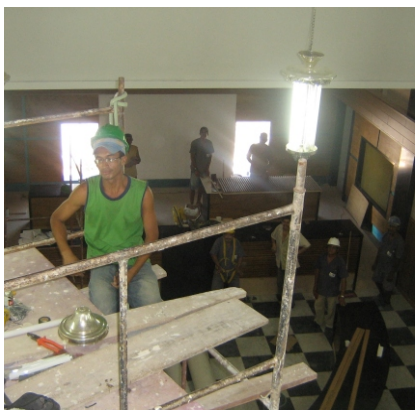
Detalhes da Sala de Sessões, durante a reforma
